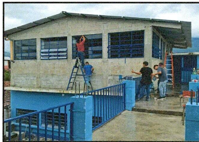
Foto 2: INSTALACIÓN DE VENTANALES EN EL 2DO NIVEL
